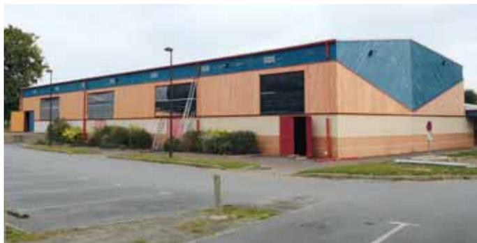
Les travaux d'amélioration thermique de la salle ont débuté ce mardi 11 septembre, après le forum des associations. Les travaux consistent à supprimer les panneaux actuels, en polycarbonate, disposant d'une isolation thermique très faible.
