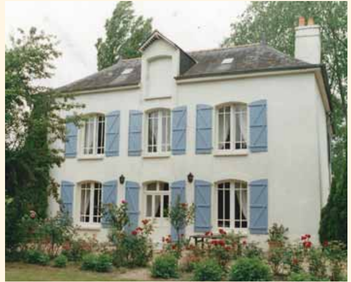
La maison du Petit Bois, route de Montreuil-le-Gast.
