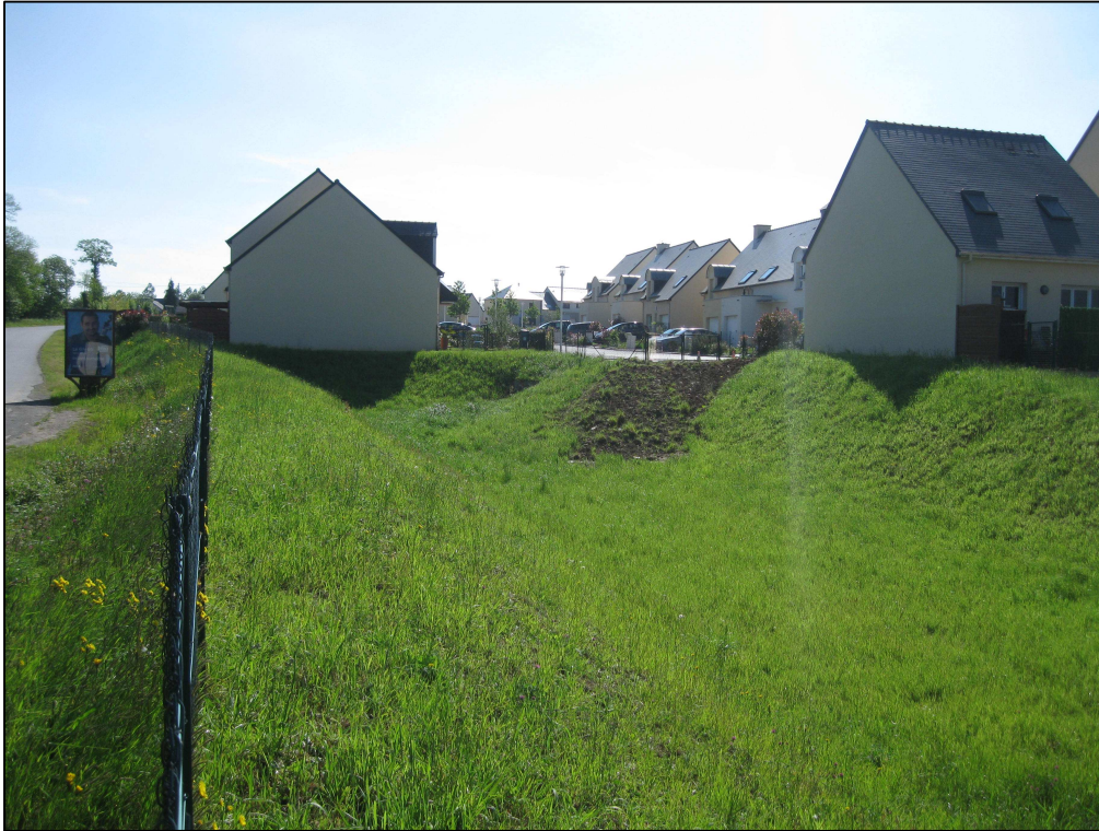
Photo 2 : Vue du bassin d'orage du lotissement « Le Clos d'Ahaut »
