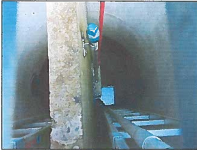
Photo 2 : Vue de l'ouvrage de sortie du bassin d'orage
