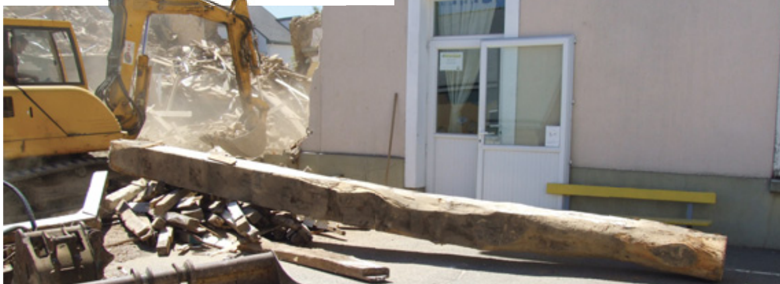
Belle poutre de la structure en terre.
